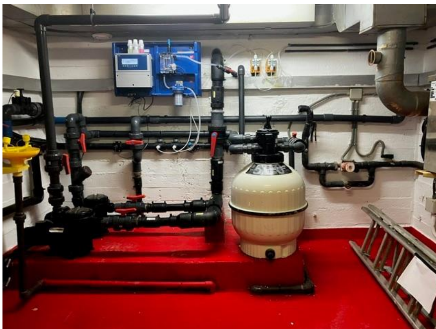
Fig. 3. Sala d'equipaments que inclou bomba de filtració i sistema de desinfecció i descalcificació.
