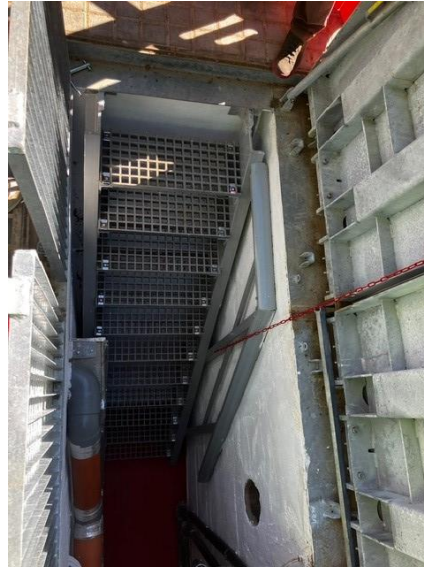
Fig. 2. Escales d'accés d'acer galvanitzat o PRCV.
