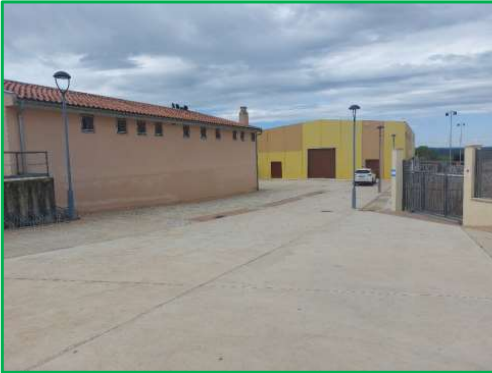
1.- Vista general, pista poliesportiva al fons edifici groc.
