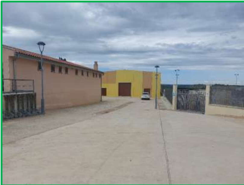
6.- Vista general carrer, sortida cables
