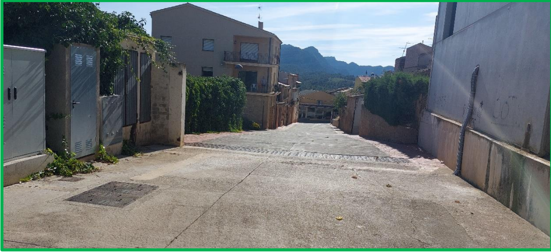
8.- Vista general carrer, sortida cables i quadre general
