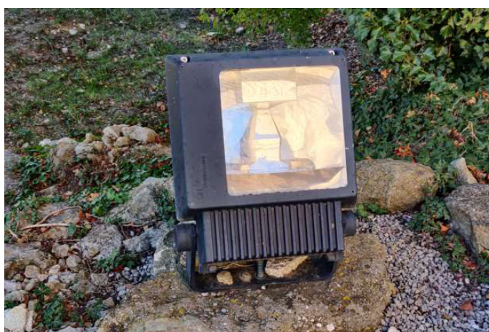
Fig.2.- Proyector con lámpara de 250 W ubicado en el núcleo de Castell de Mur
