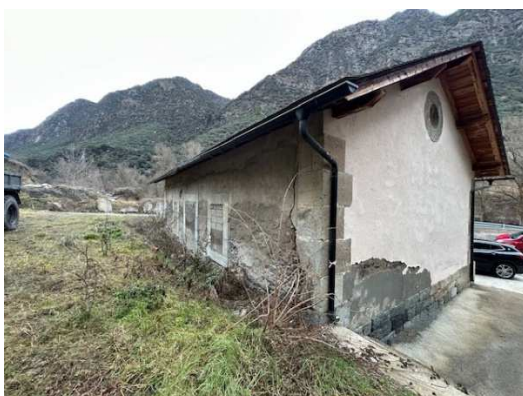
Imatge 03. Humitats en l'exterior del Tanatori d'Escaló.
