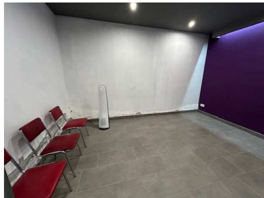
Imatge 02. Humitats en l'interior del Tanatori d'Escaló.
