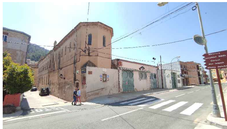
FAÇANA NORD-EST/NORD-OEST (N-E/N-O)
