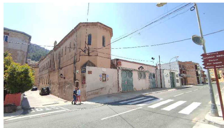
FAÇANA NORD-EST/NORD-OEST (N-E/N-O)
