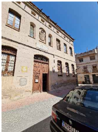
FAÇANA SUD-EST (S-E)
