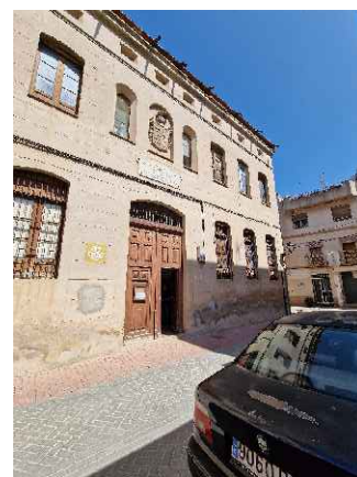
FAÇANA SUD-EST (S-E)
