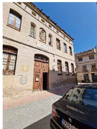
FAÇANA SUD-EST (S-E)
