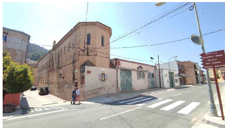
FAÇANA NORD-EST/NORD-OEST (N-E/N-O)
