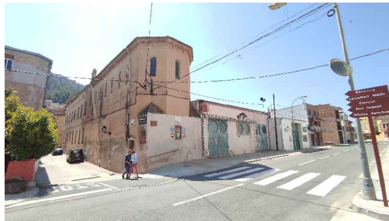
FAÇANA NORD-EST/NORD-OEST (N-E/N-O)
