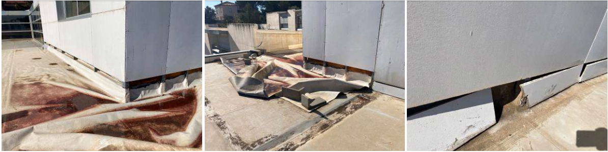
Fotos on s'observa la deformació/ruptura de les plaques i com la intempèrie/ UV han ressecat el posterior segellat.
