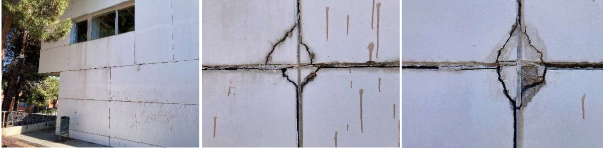
Fotos on s'observa la deformació/ruptura de les plaques i com la intempèrie/ UV han ressecat el posterior segellat.
