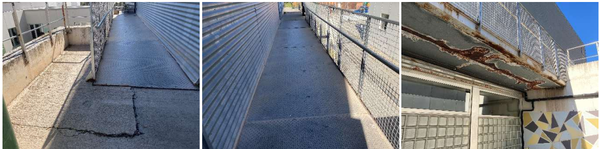
Fotos de la passera on s'observa l'avançat estat d'oxidació del diferents elements metàl·lics
