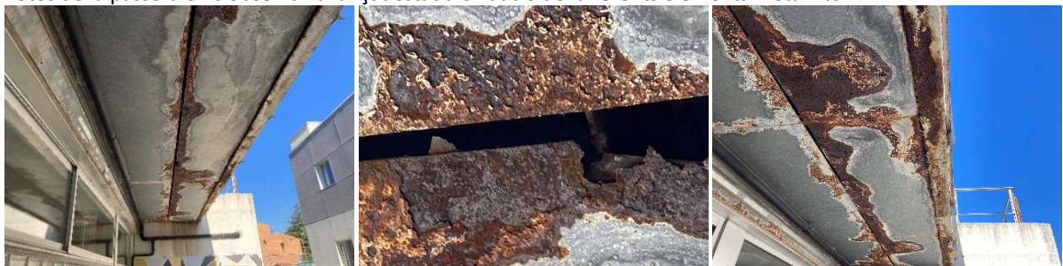
Fotos de la passera on s'observa l'avançat estat d'oxidació del diferents elements metàl·lics
