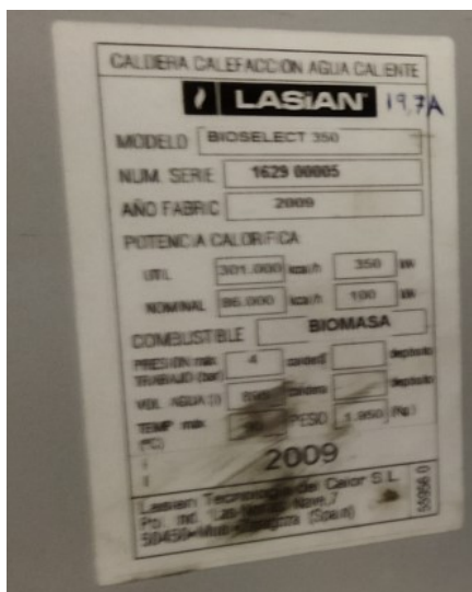
Imatge 1. Placa de la caldera actual instal·lada LASIAN Bioselect 350
