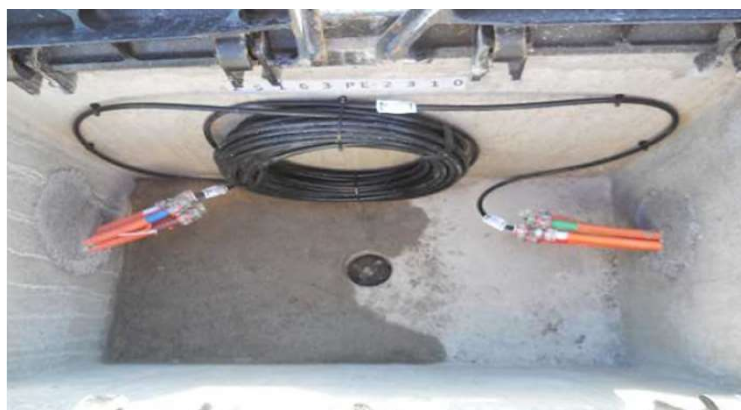
Exemples Terminació microductes en pericó
