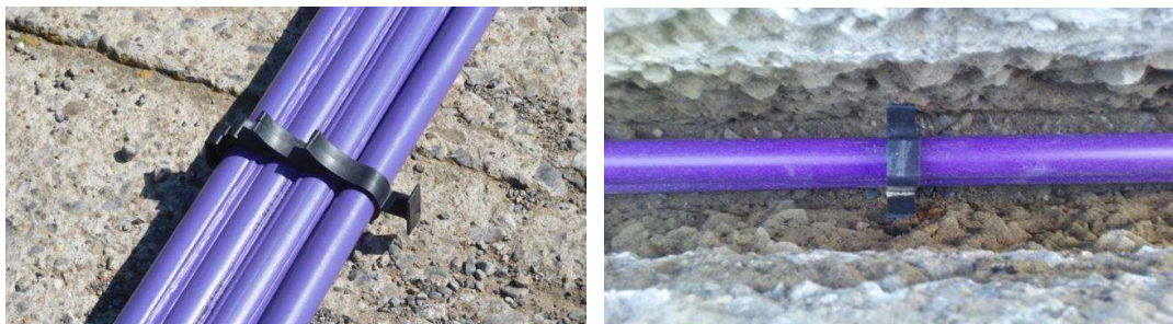
Centrador plàstic per homogeneïtzar la distribució del morter.
