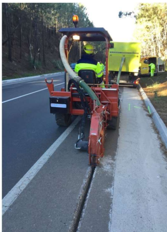
Exemple de treballs d'obertura de la microrasa
