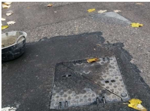
Exemple pericó tipus B2 en Calçada (tapa quadrada)
