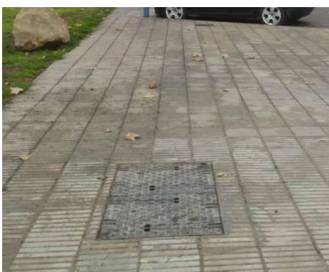
Exemple pericó tipus C2 en Vorera
