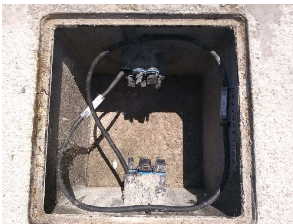
Exemple de pas de cable per pericó
