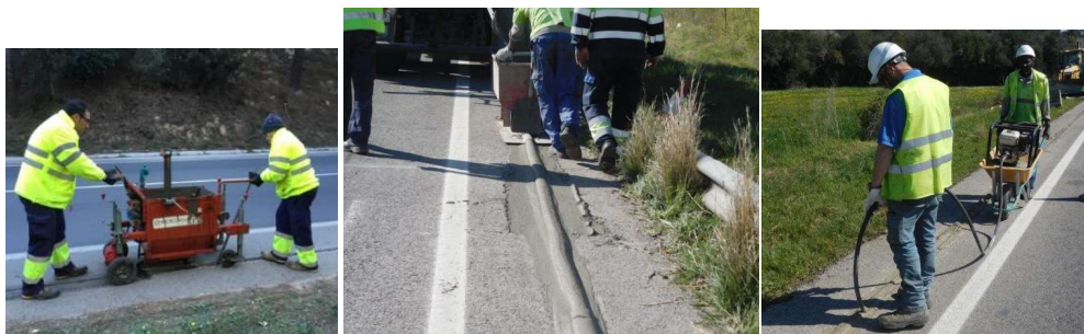
Exemple de treballs de rebliment de la rasa.
