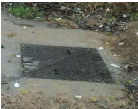
Exemple pericó tipus B2 en terres
