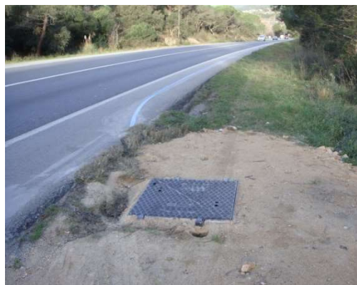
Exemple de l'estat de la canalització acabada
