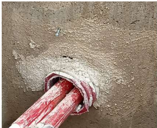
Exemple Terminació fil conductor en pericó
