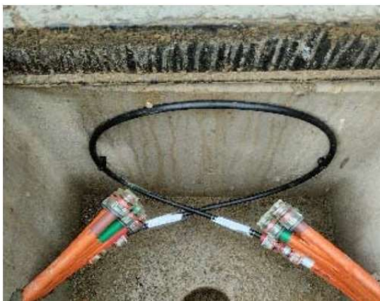
Exemples Terminació microductes en pericó
