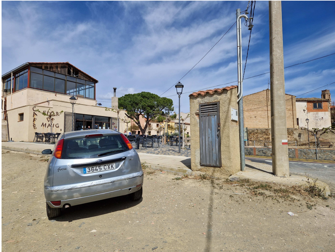
Emplaçament punt de recarrega al costat de l'armari de comptadors de l'enllumenat públic al Casal
