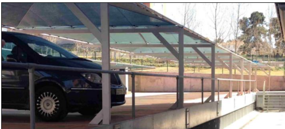
Figura 5. Aparcament on s'ubicaran les estacions de recarrega de vehicle elèctric.
