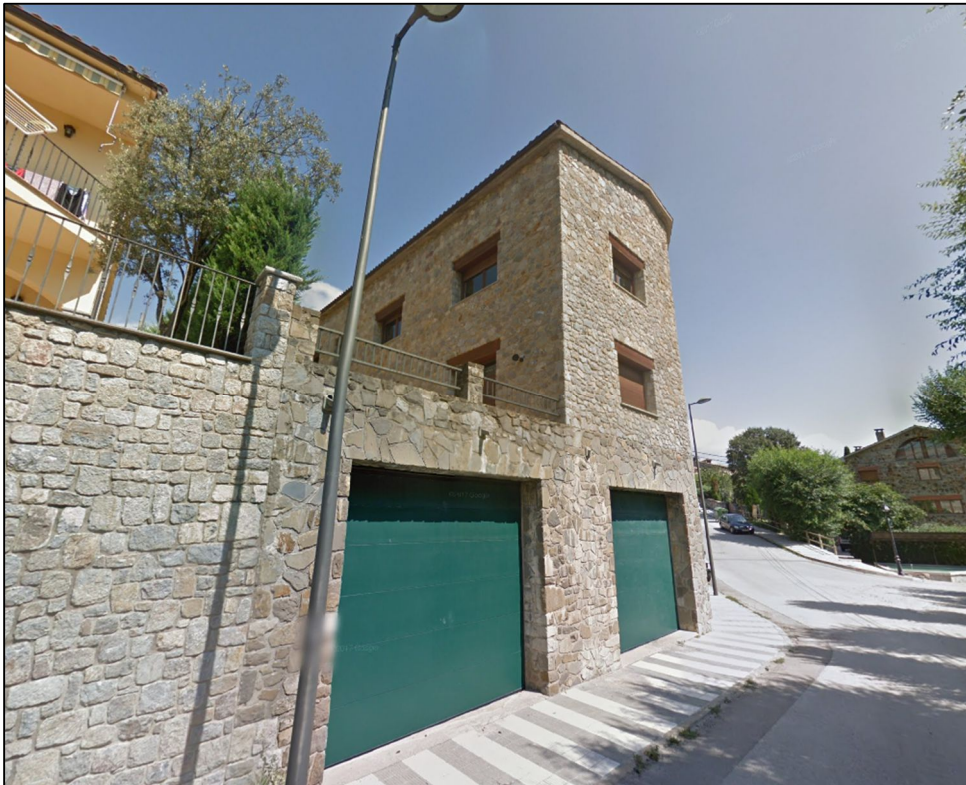
Figura 2. Façana de l'edifici
