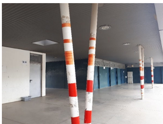
Estructura exterior existent
