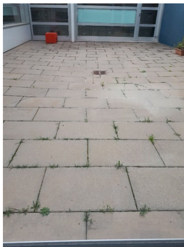
Pati exemple pavimentat
