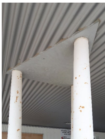
Estructura exterior existent
