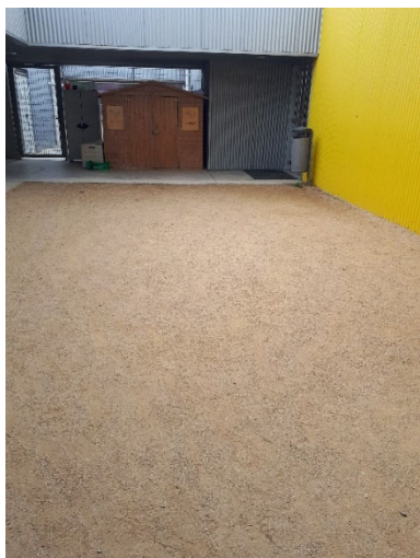
Pati existent a pavimentar
