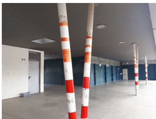
Estructura exterior existent
