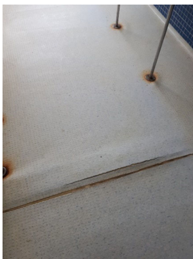
Paviment vinil existent
