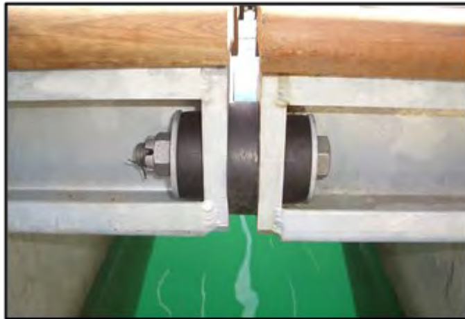
Imatge 1. Detall dels elements d'unió entre pantalans
