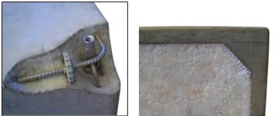
Imatge 4. Detalls casquets de fixació del cargols i nucli de poliestirè expandit.
