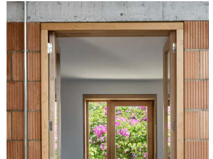
Exemple de fusteria sense tapetes, amb galze al marc fixe i premarc de la mateixa fusta
