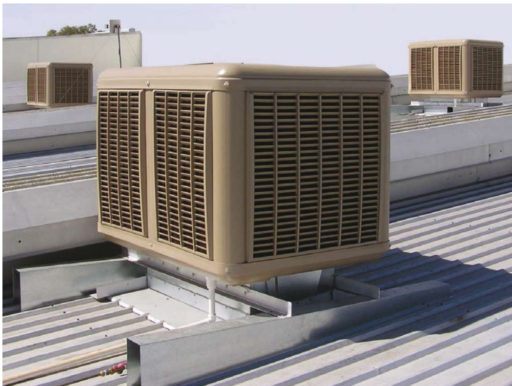
Imatge 10. Vista d'exemple d'un evaporatiu i de l'estructura de suport per adaptar-lo a una coberta inclinada.
