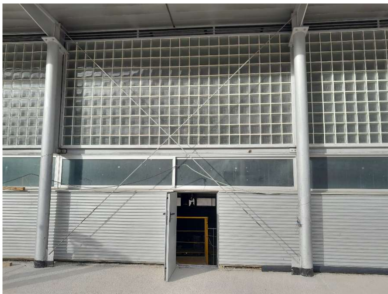
Imatge 6. Vista de la façana principal de la nau, on es pot observar la reixa lineal d'entrada d'aire en la zona superior i les obertures practicables corredisses.
