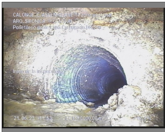
Foto: 1_1_2_21062023_115340_A.JPG 0m, Inicio de la inspección
