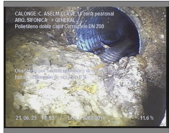
Foto: 1_1_1_21062023_115320_B.JPG 0m, Obstáculo por sedimentaciones desde 12 hasta 12 horas. Reducción de sección 0 %
