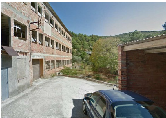
Vista final C/ del Sindicat
