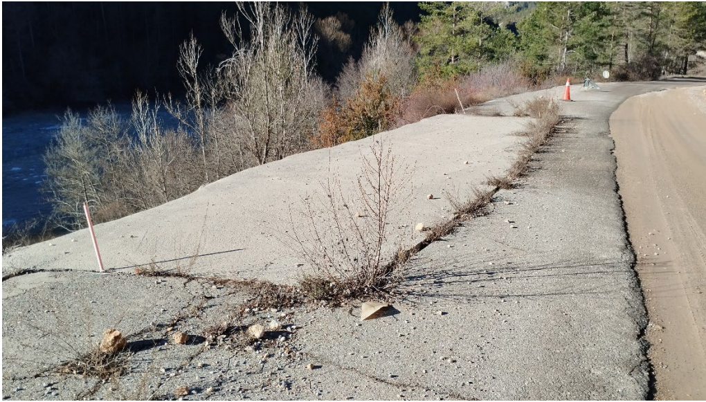
Estat actual del tram a estabilitzar
