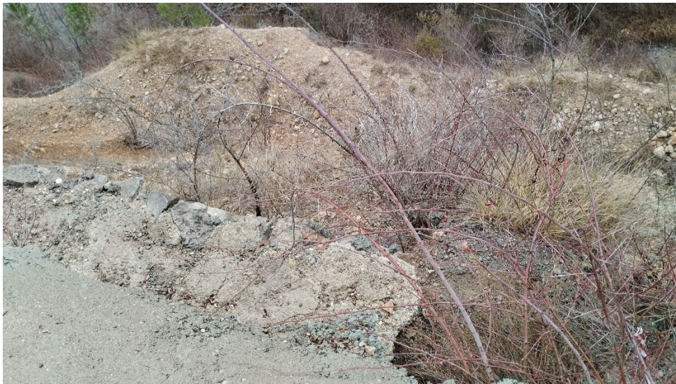
Estat actual del tram a estabilitzar
