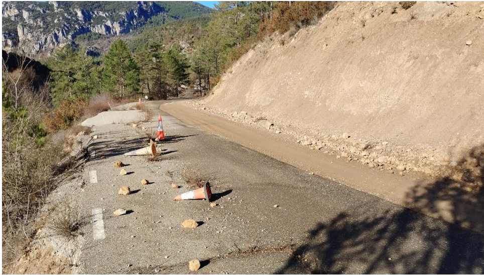
Estat actual del tram a estabilitzar
