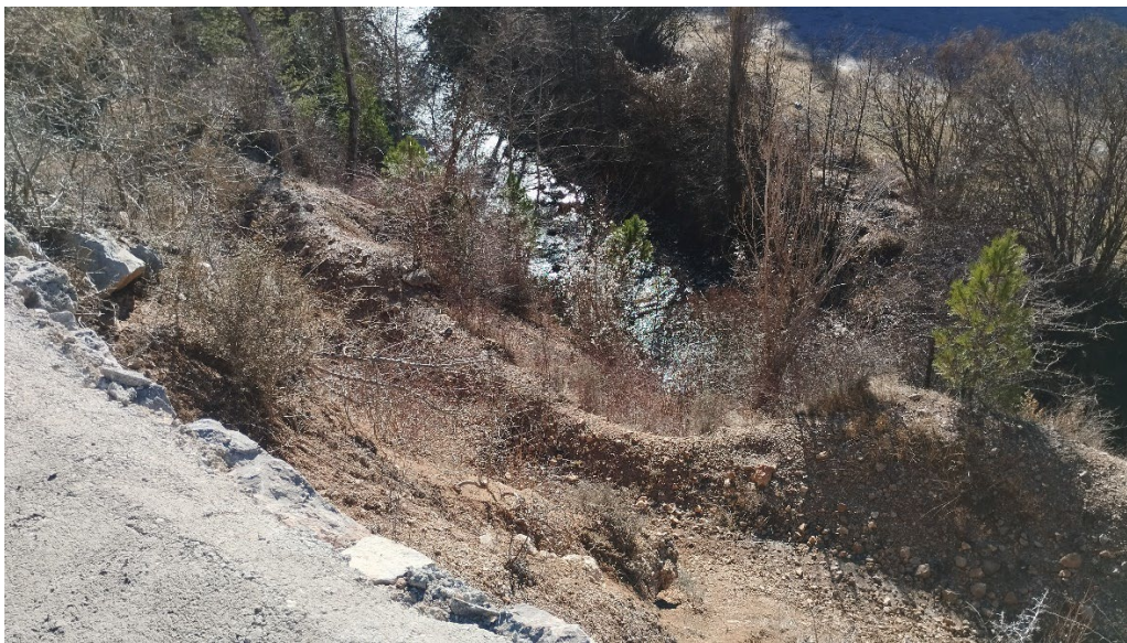
Estat actual del tram a estabilitzar
