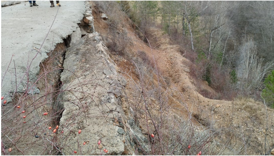
Estat actual del tram a estabilitzar
