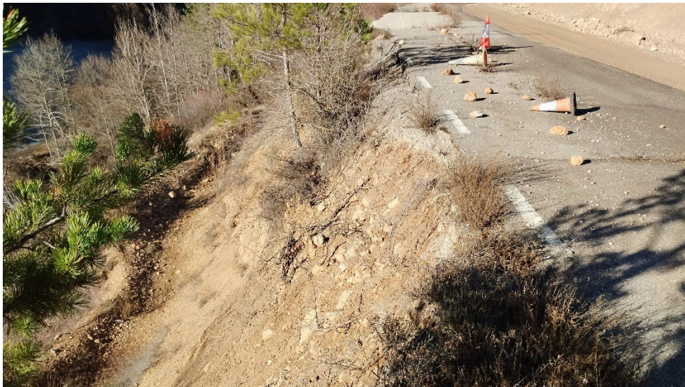
Estat actual del tram a estabilitzar
