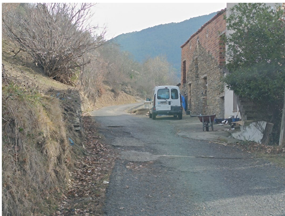
Camí d'accés a Torres d'Alàs - Estat actual
