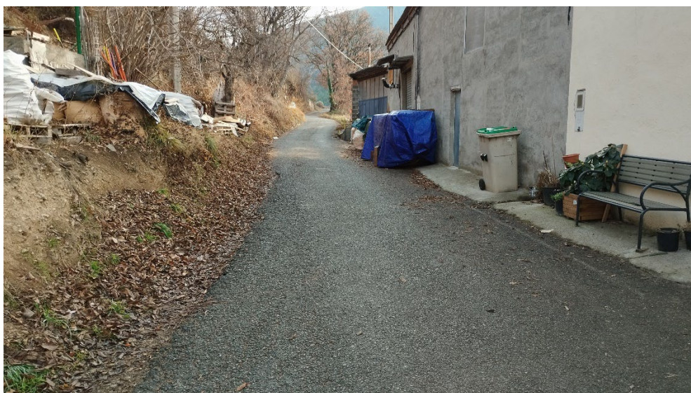
Camí d'accés a Torres d'Alàs – Estat actual
