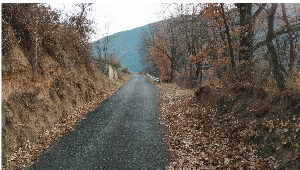
Camí d'accés a Torres d'Alàs – Estat actual
