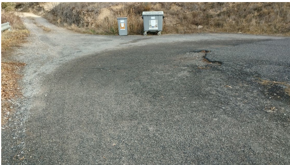
Camí d'accés a Torres d'Alàs - Estat actual
