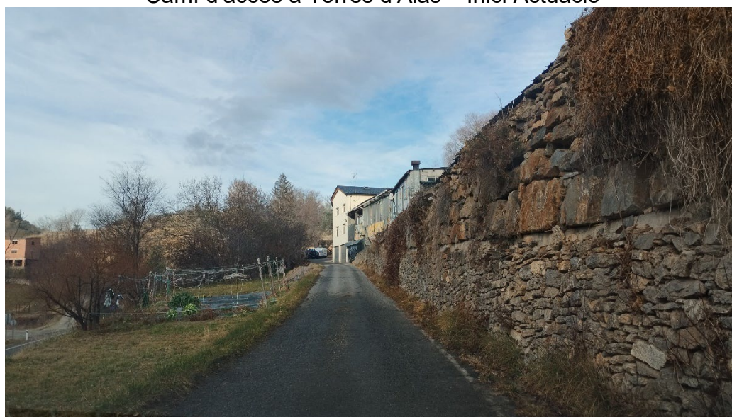
Camí d'accés a Torres d'Alàs – Estat actual
