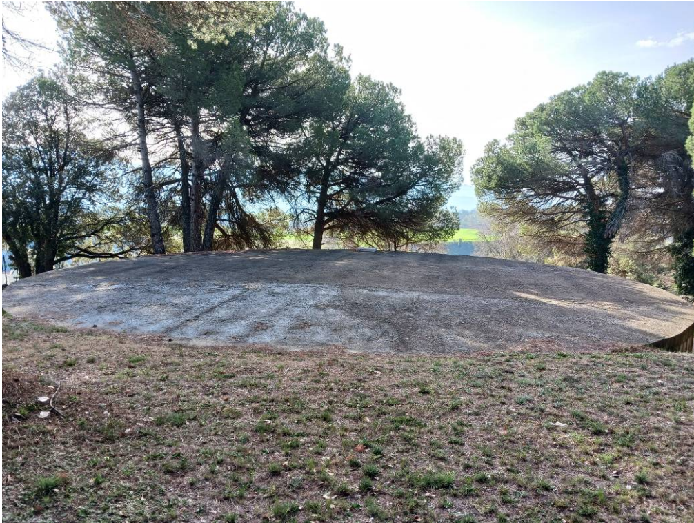
Vista del dipòsit des de dalt
