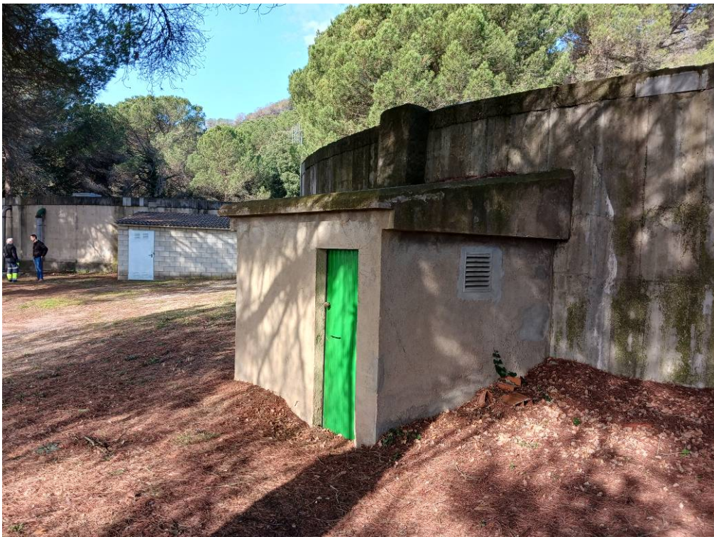
Caseta de vàlvules exterior
