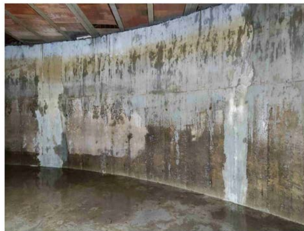
F05 - Filtracions verticals en trams interiors dels murs
