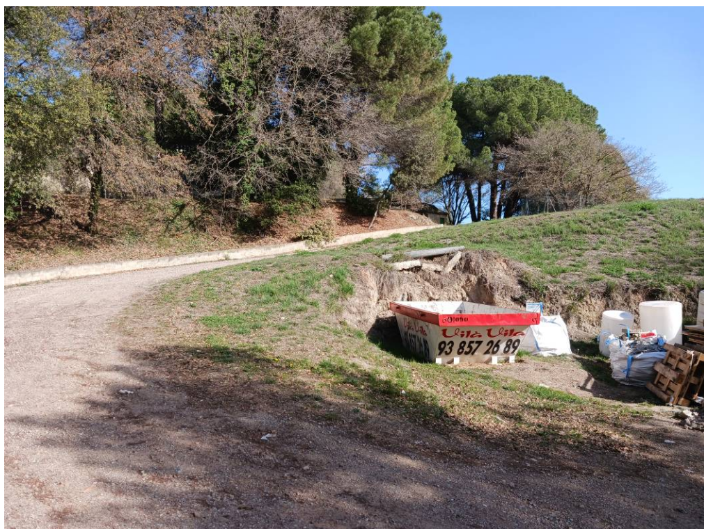
Vial interior d'accés a la plataforma dels dipòsits
