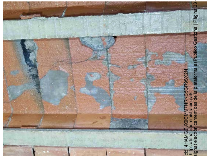
F23 - Vista interior de fissura en la capa de compressió de coberta. Absència de revoltos per trencament i despreniment
