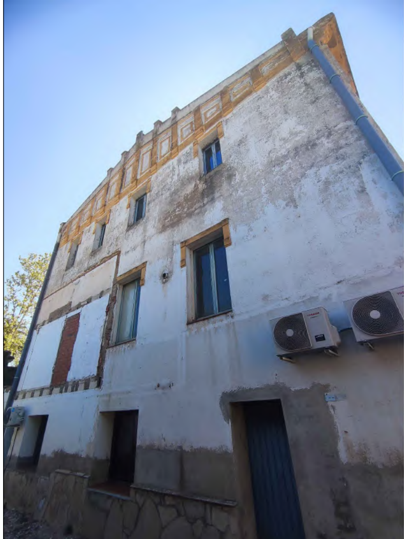
Façana lateral (Nord-Est)
