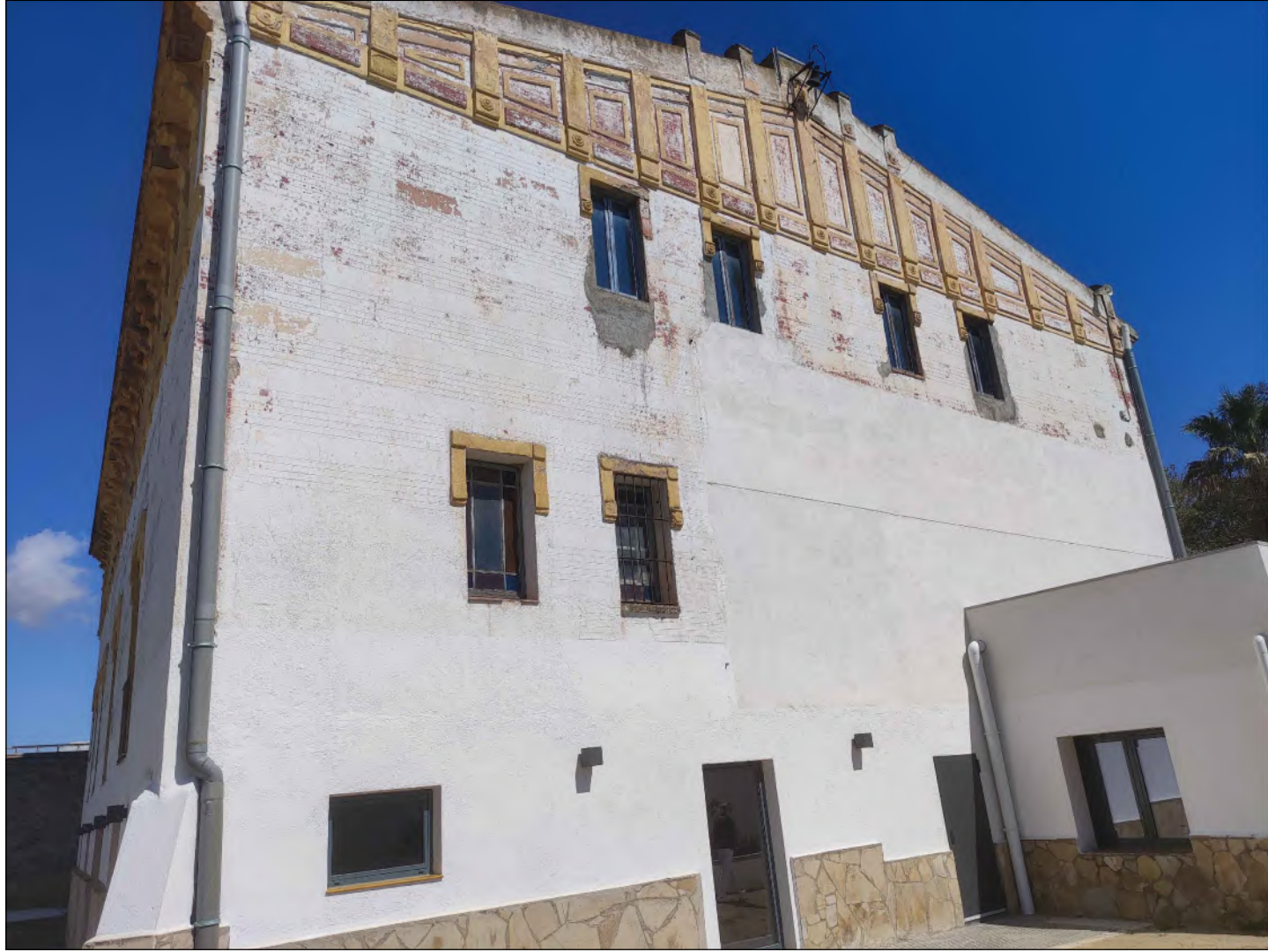
Façana lateral (Sud-Oest)
