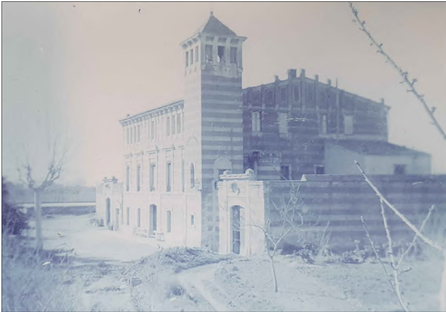
Façana lateral (Nord-Est)
