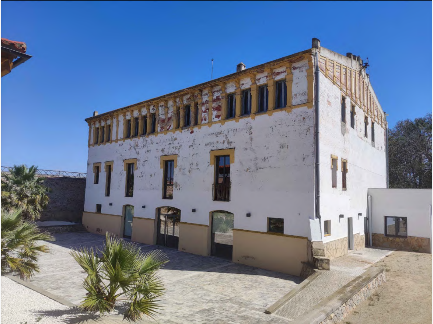
Façana posterior (Nord-Oest)
