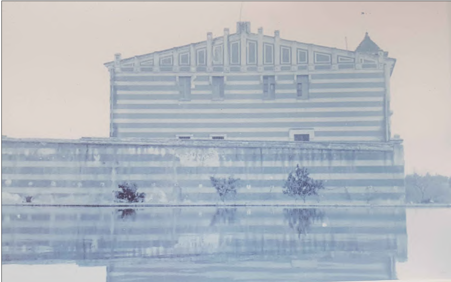
Façana lateral (Sud-Oest)
