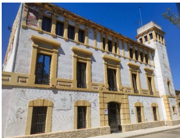
Fotografia actual de la façana principal S-E de Mas Bover.
