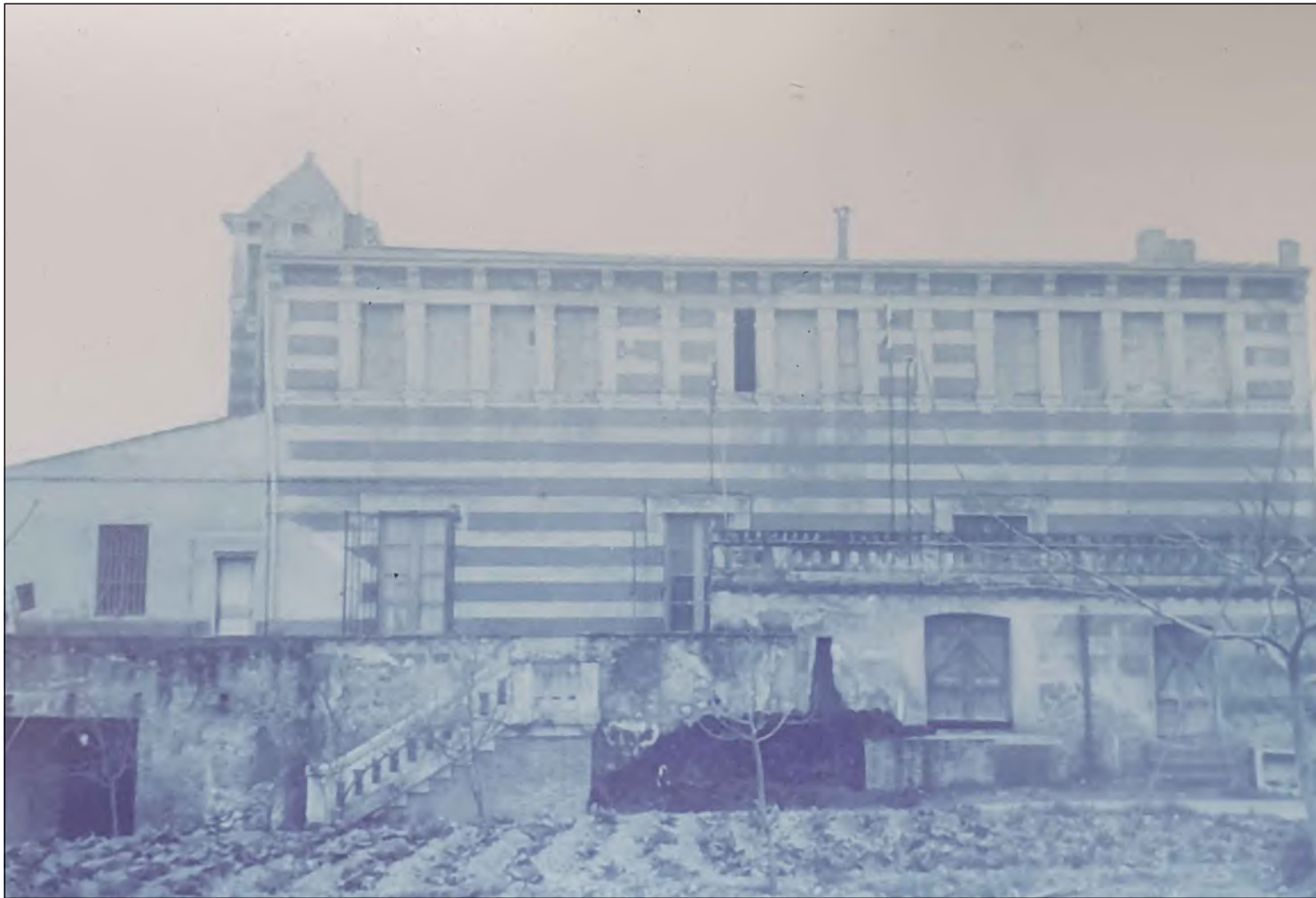
Façana posterior (Nord-Oest)
