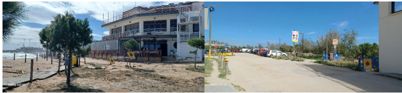
Imatge 15: Tancament dels accessos del costat oest de la platja del Cavaíó. Data 28.03.2024.
