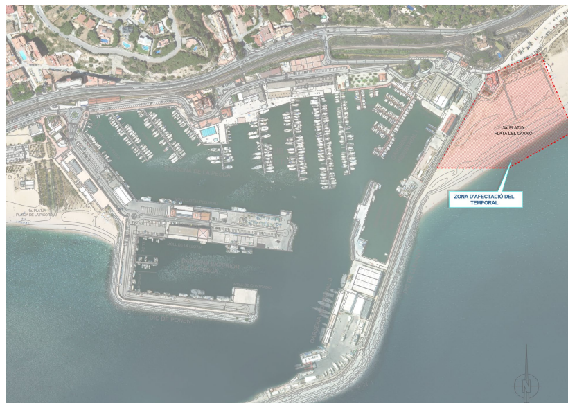
Imatge 1: Ubicació zona afectació del temporal al port d'Arenys de Mar.
