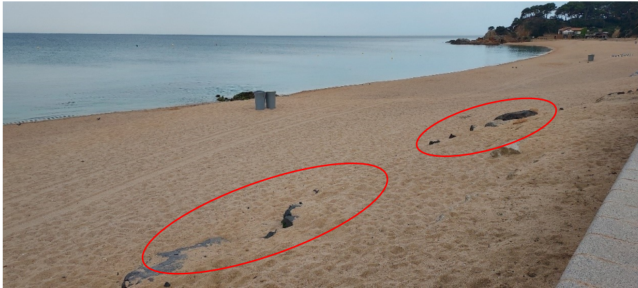
Acumular sorra a la part posterior per cobrir roques escullera
