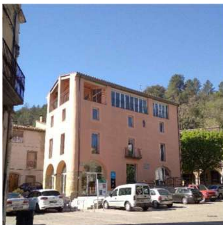
Imatge 1: Edifici Llar jubilats
