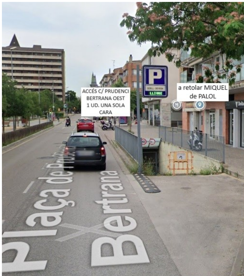
Imatge 4: Vista plaça Prudenci Bertrana amb ubicació actual rètol lluminós entrada oest a substituir per un rètol lluminós d'una sola cara font: Google
