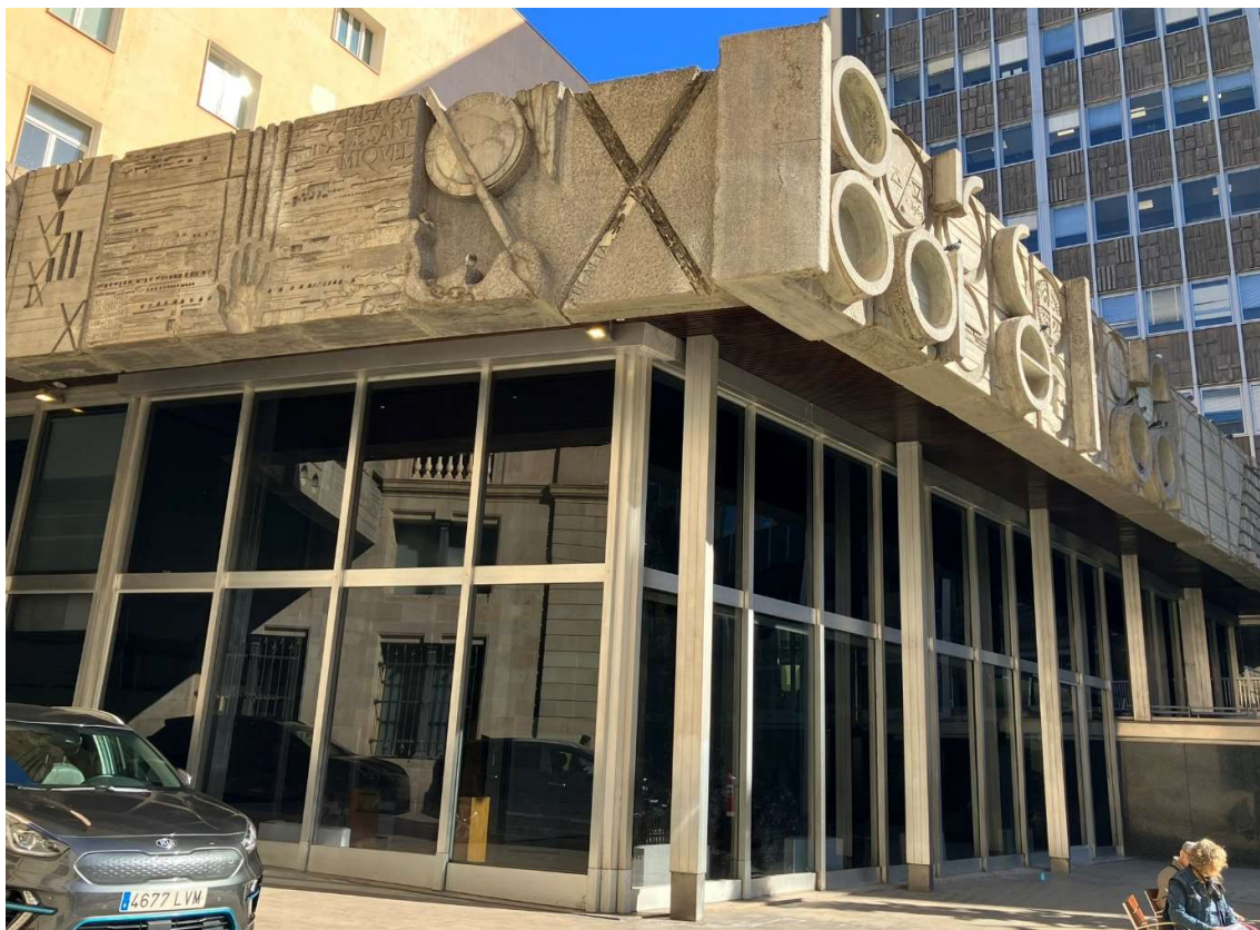
Façana volum del vestíbul des del carrer Font de Sant Miquel
