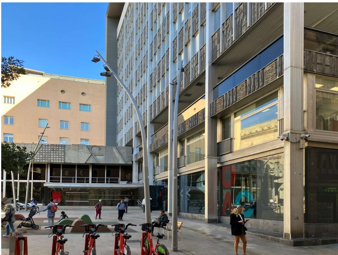
Sòcol de l'edifici Novíssim i volum del vestíbul.
