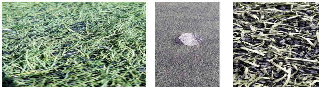
Estat actual gespa artificial
