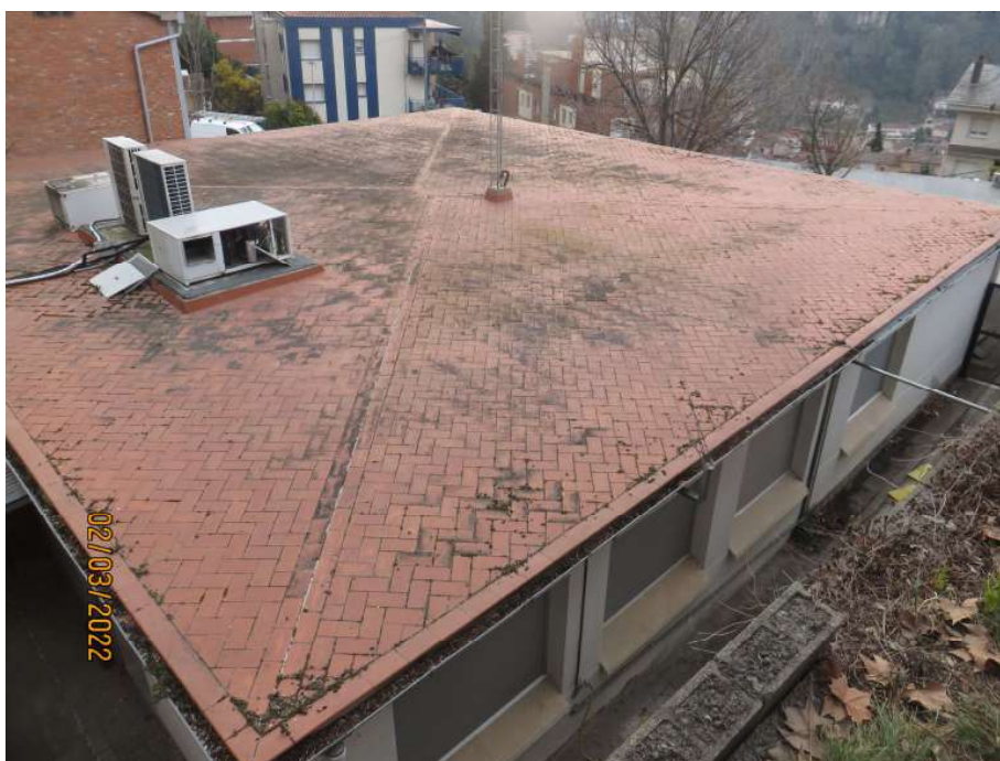
Coberta edifici Prefectura de la Policia Local de Corbera de Llobregat
