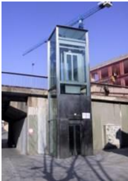
Fig. 3.- Ascensors amb senyals descatalogades i que no disposa de panell LED informatiu.
