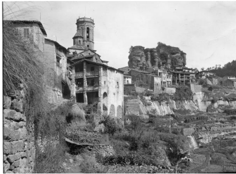
1935 Vista parcial poble C. Vidal i Ventosa, Barcelona atracció, 180081 Font: Arxiu SPAL
