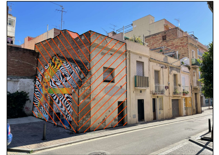
EDIFICI A ENDERROCAR
