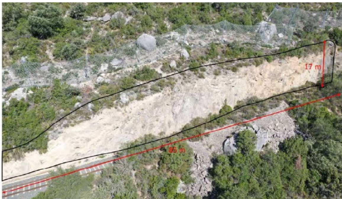
ESQUEMA - Malla triple torsió + reforç de cable 3x3
