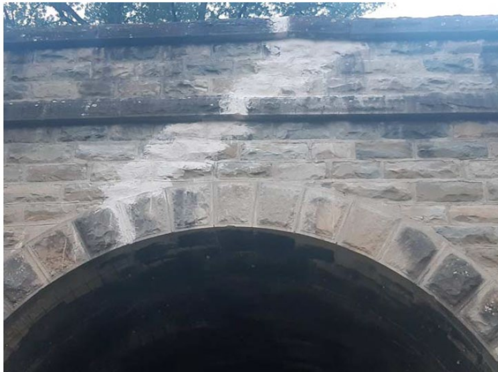
REPARACIÓ DE FISSURA AL FRONTAL
