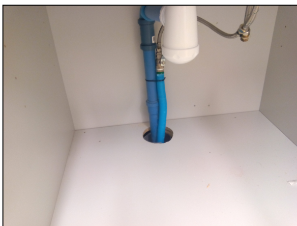
Detall del sanejament i fontaneria que alimenta una aigüera i el sostre de la part inferior.
