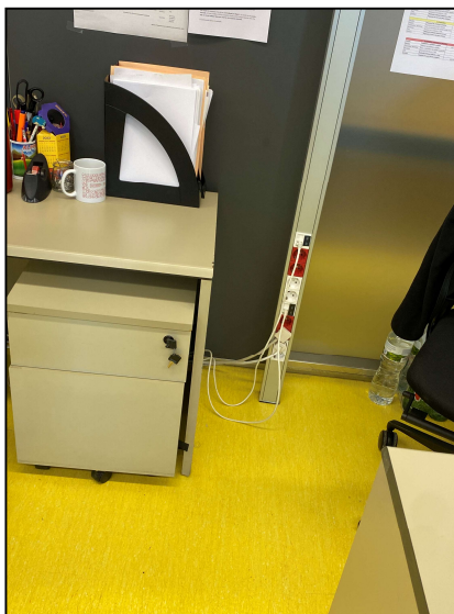
Mecanismes en instal·lació vertical
