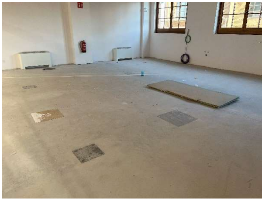
Imatges de les arquetes de registre integrades en el paviment amb els conductes i cablejats
