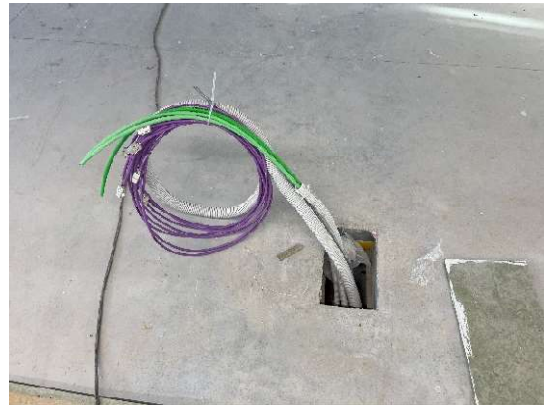
Imatges de les arquetes de registre integrades en el paviment amb els conductes i cablejats
