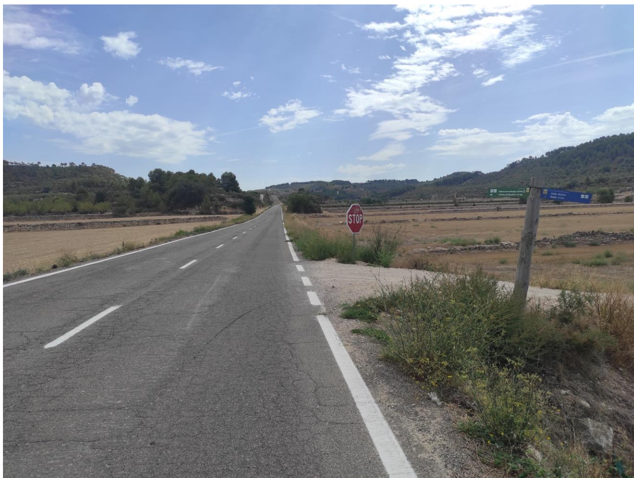
Imatge recent de la connexió del camí de Maldanell amb la Carretera LP-2335
