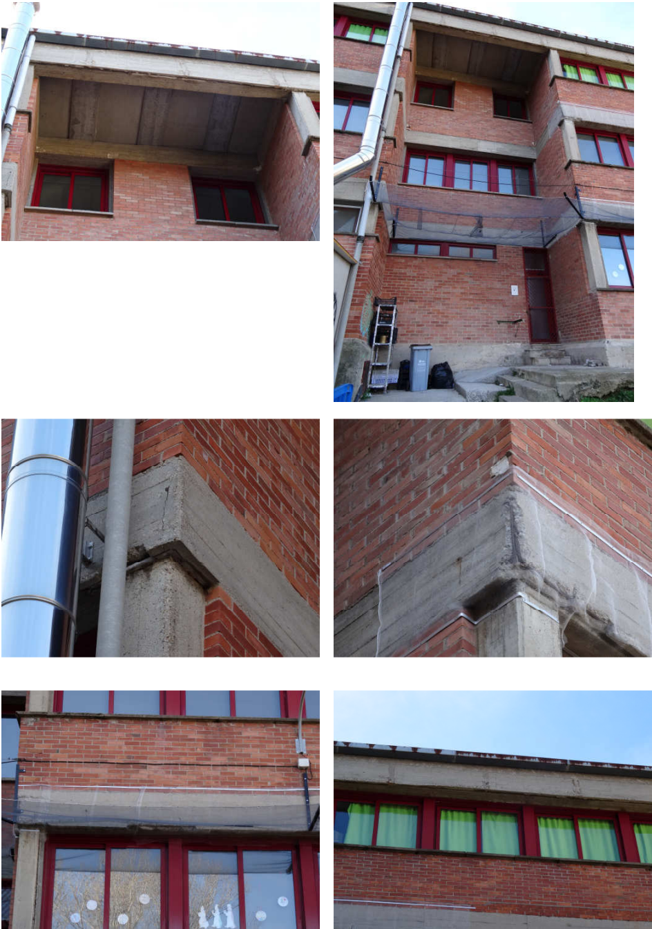
Reparació i protecció elements de formigó estructural de les façanes de l'escola Santa Eulàlia C/Olvan s/nº, 08600-BERGA
