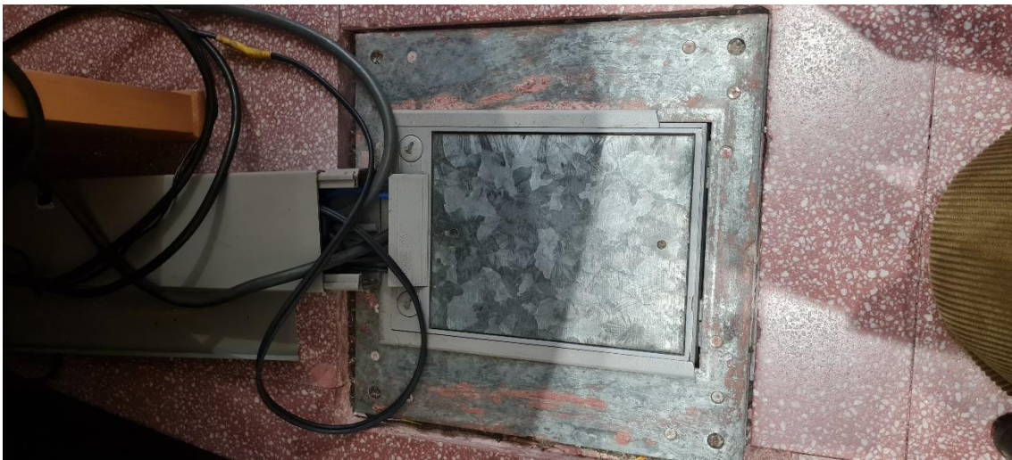
Imatge 14: Canal a terra que va des de la taula del docent fins a les cabines d'interpretació (aules d'interpretació 1 i 3).
