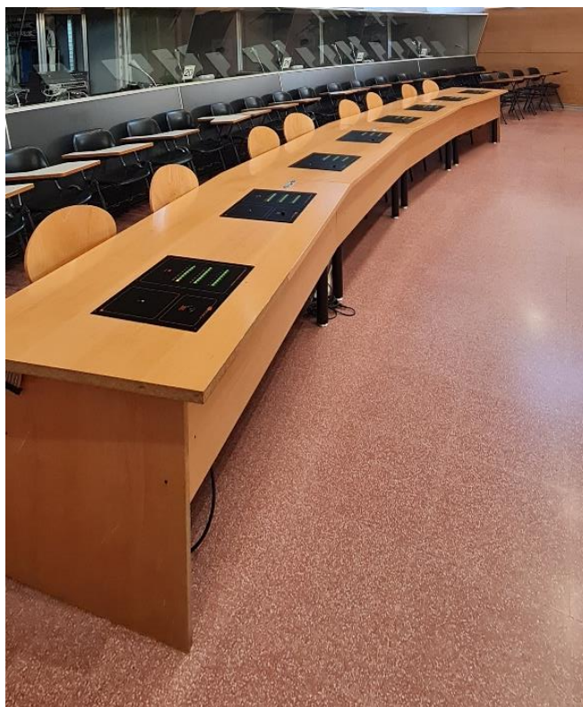
Imatge 5: Taula addicional amb selectores de cabines a l'aula d'Interpretació 1. Les plaques de color fosc son el que queda d'un equipament anterior ara inutilitzades.
