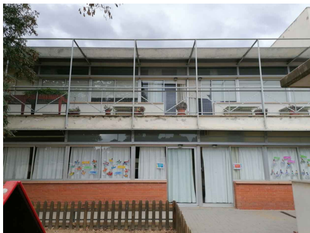
FAÇANA SUD-EST ALA SUD
