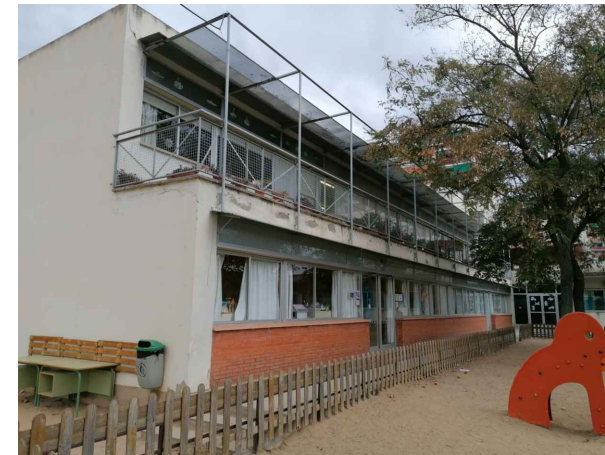
FAÇANA SUD-EST ALA SUD
