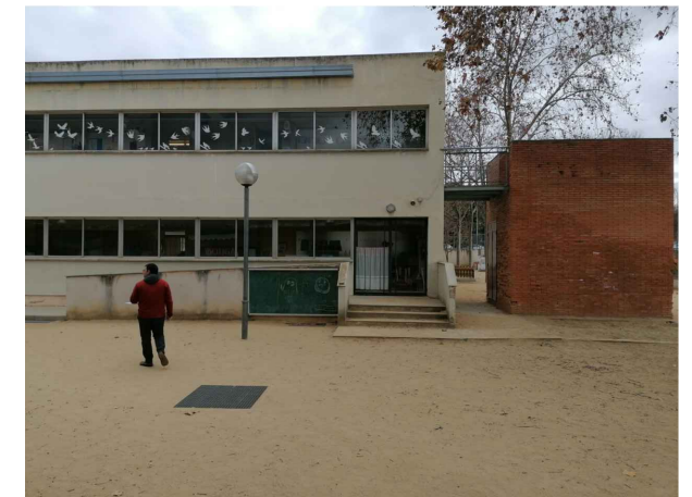
FAÇANA NORD-OEST ALA SUD
