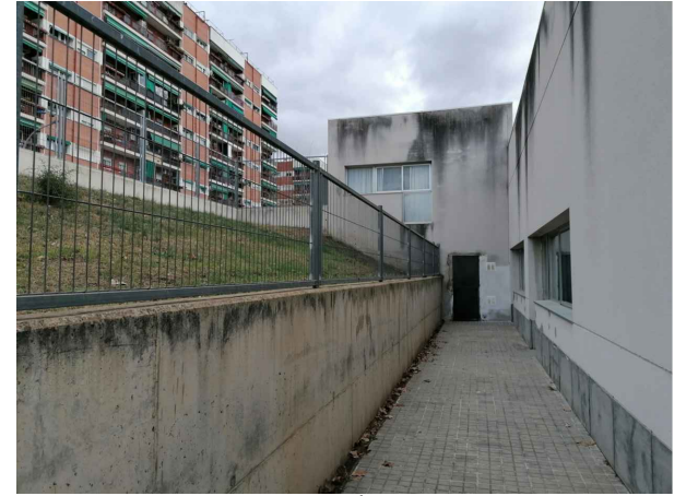
FAÇANA POSTERIOR GIMNÀS
