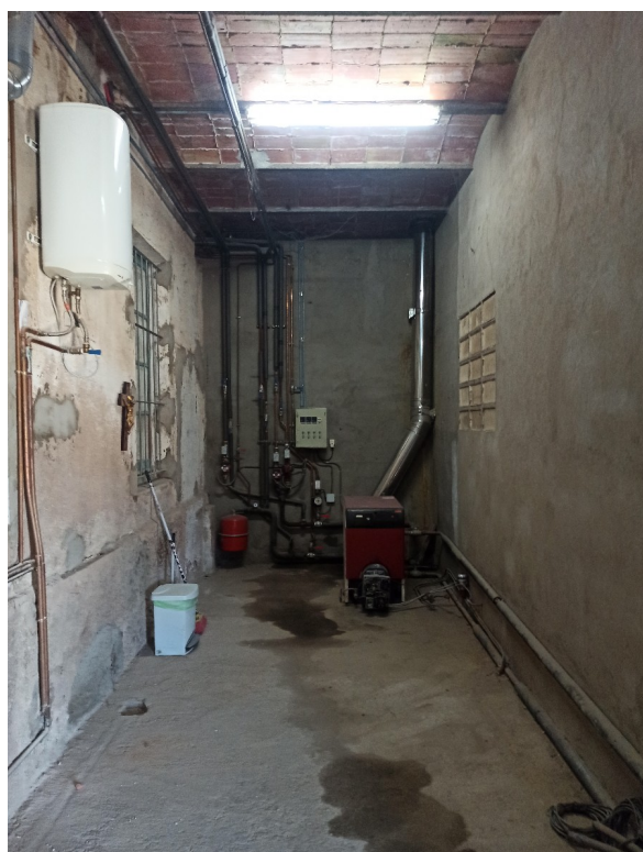
Fotografies de la caldera de gasoli existent i de la sala de calderes. S'hi pot observar el col·lector i els diferents circuits que conformen la xarxa de calor.
