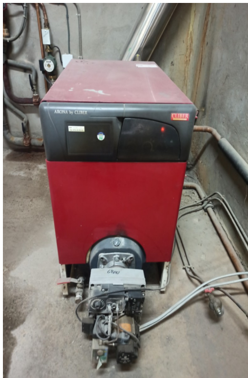
Fotografies de la caldera de gasoli existent i de la sala de calderes. S'hi pot observar el col·lector i els diferents circuits que conformen la xarxa de calor.
