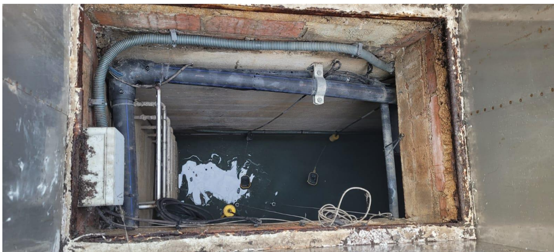
Figura 7. Dipòsit municipal. Interior càmera humida.
