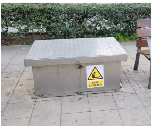
Figura 6. Càmera humida. Exterior i senyalització
