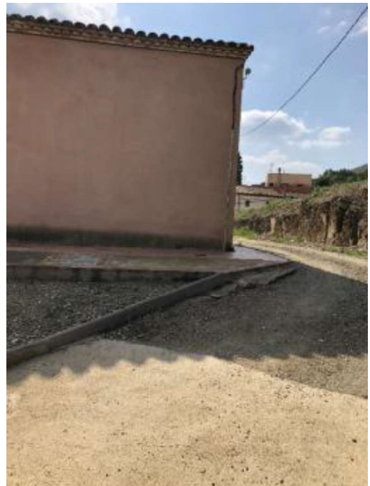
Cantonada per on hi haurà el baixant fins al terra
