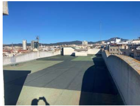
Vista coberta estat actual
