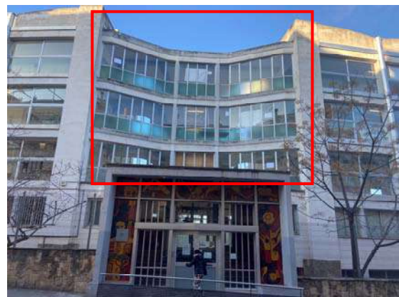
Finestres a substituir
