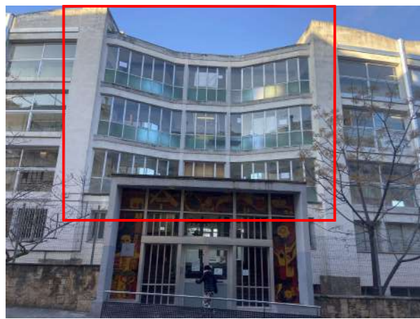
FAÇANA EDIFICI A CARRER DEL GERMÀ JOAQUIM
