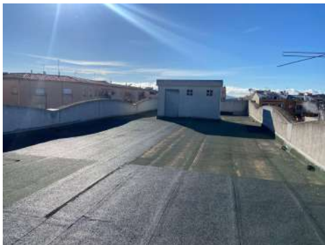
Vista coberta estat actual
