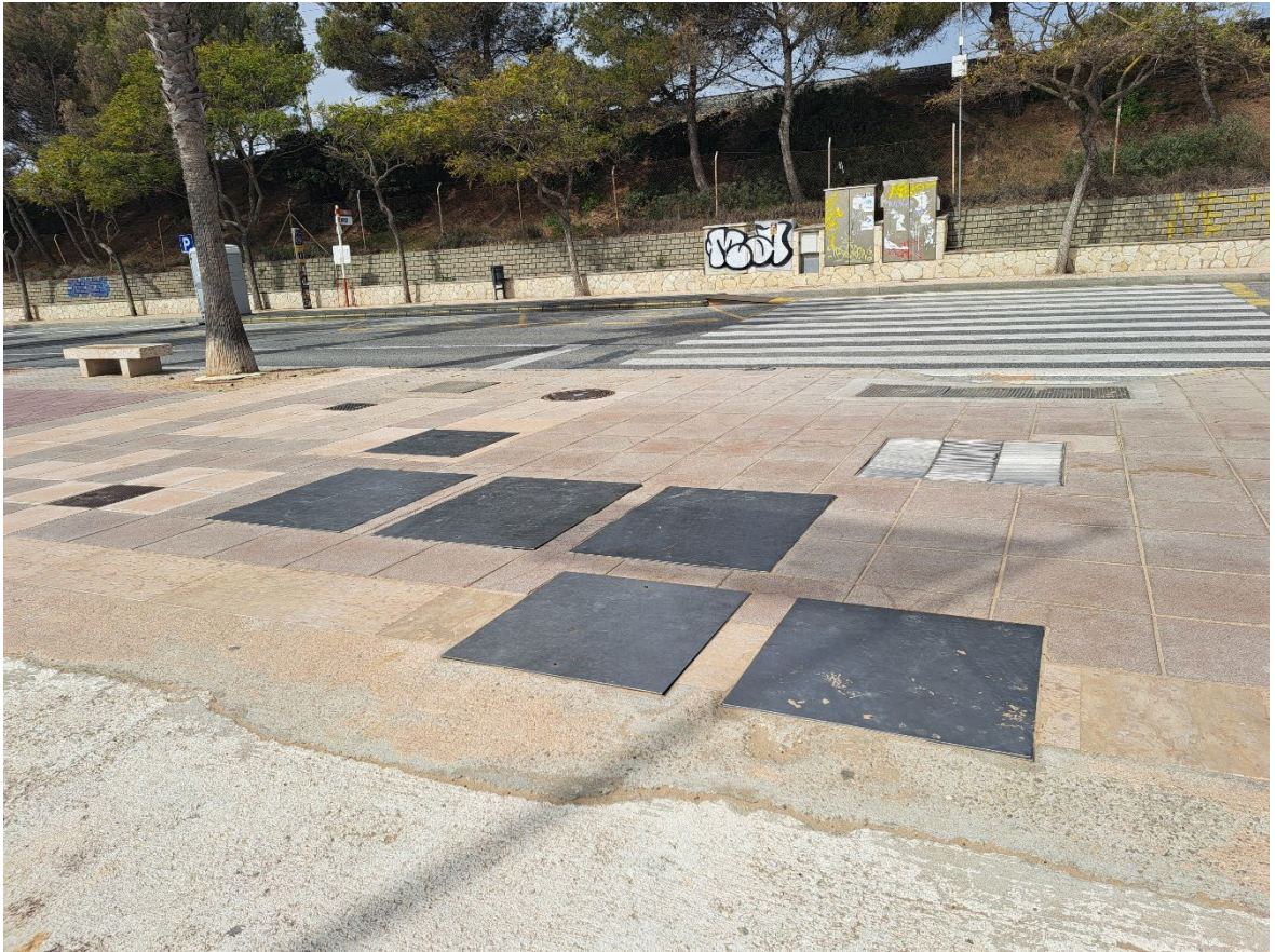
Foto Núm 5: Vista de les tapes d'accés a l'aljub i a les bombes de l'EB Arrabassada on aniran sis tapes assistides individuals.
