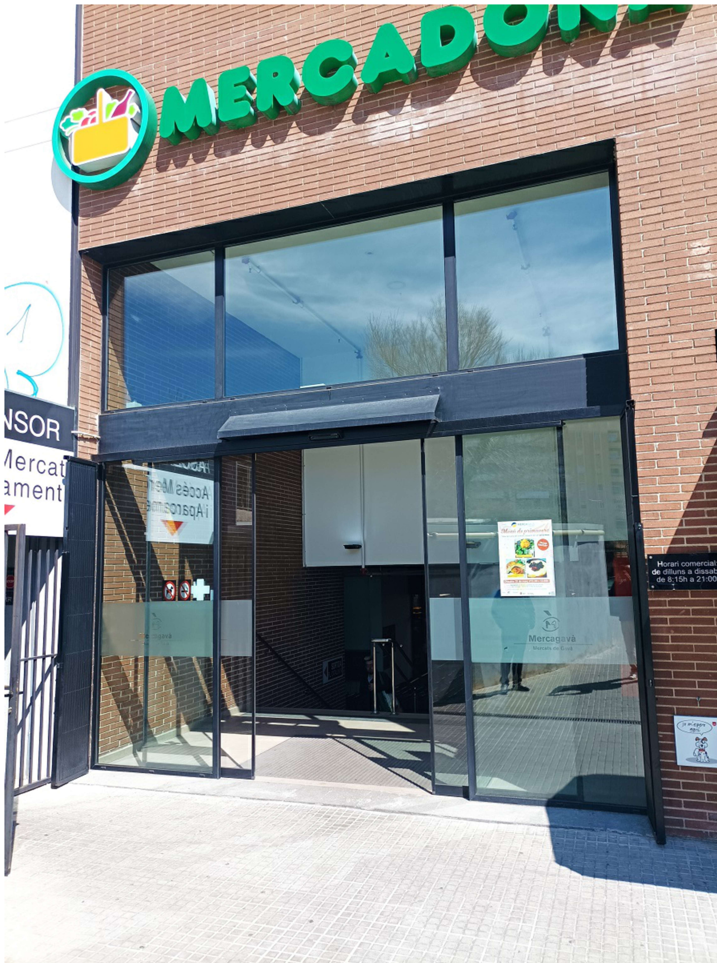
V02. Vista desde l'exterior de l'accés
