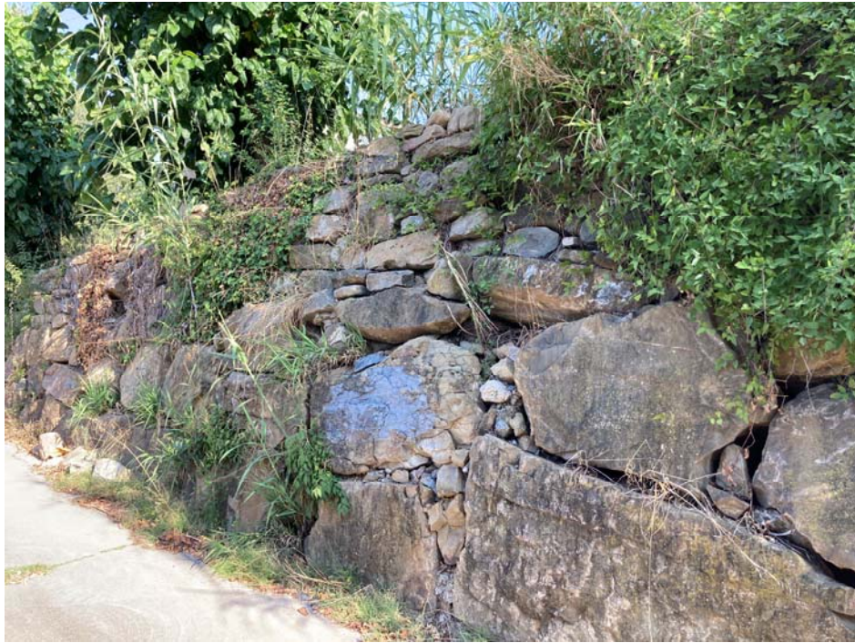
Imatge del mur d'escullera a reparar
