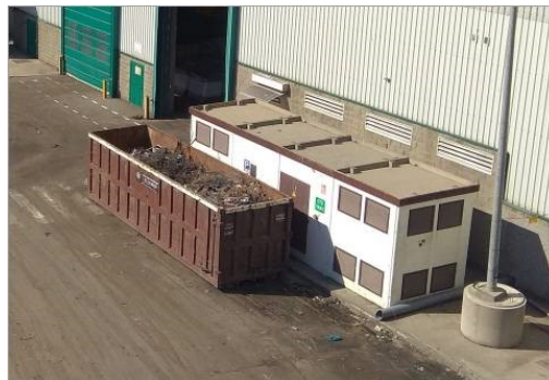
Vista del CT-TRAT-2 a desmantellar
