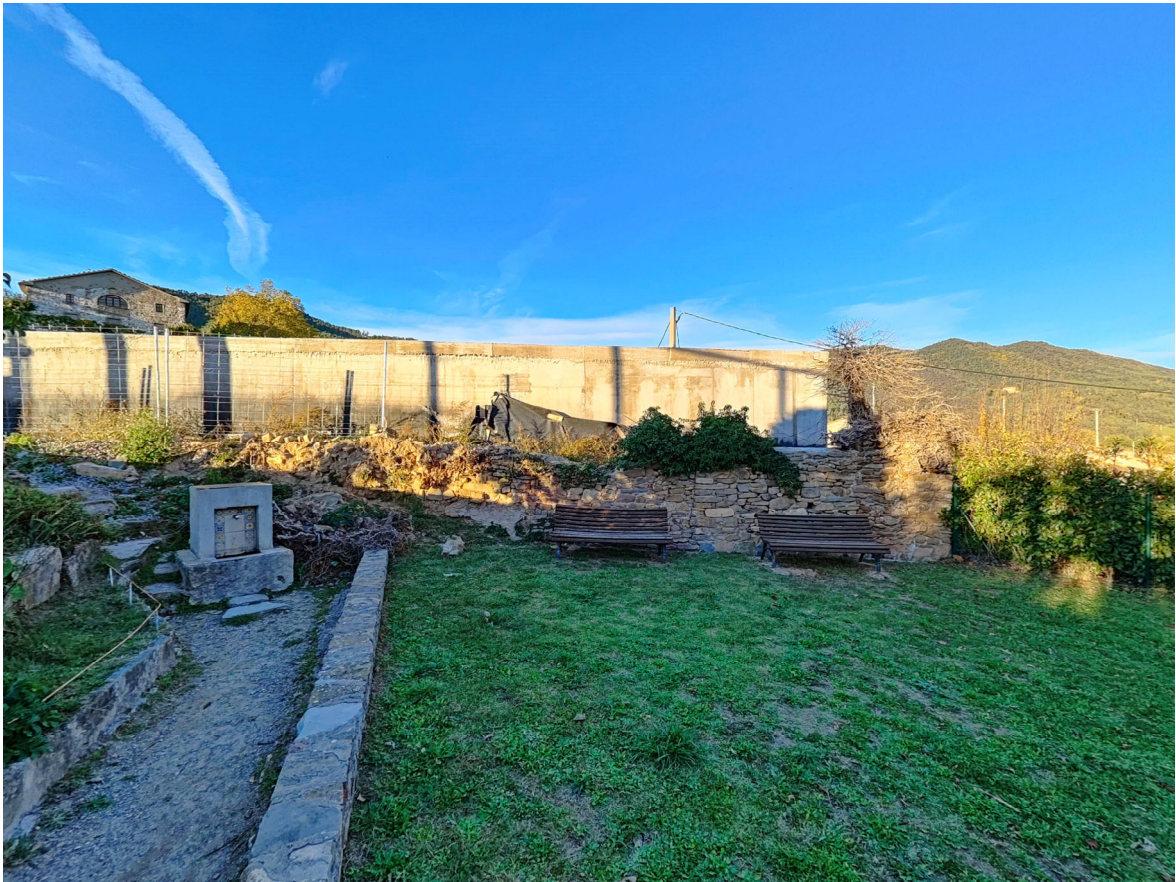
Façana sud del magatzem municipal.
