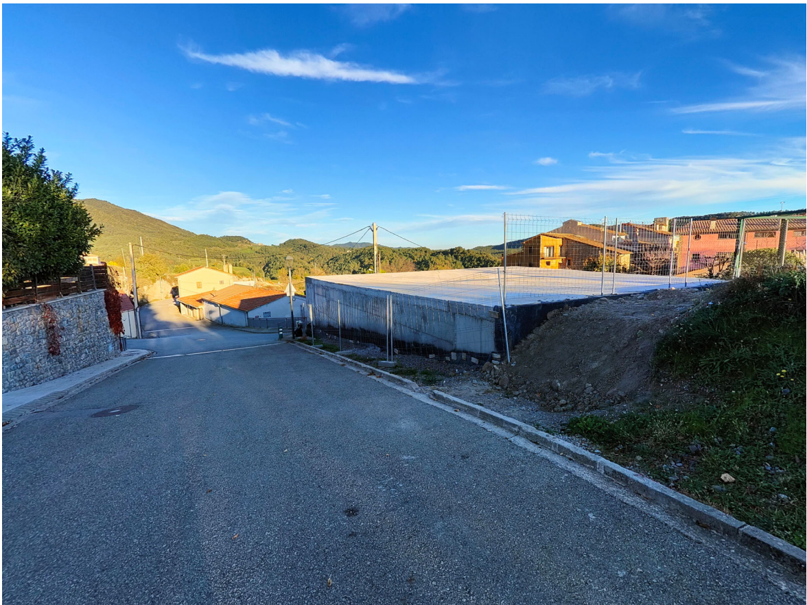
Façana nord del magatzem municipal
